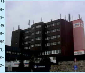
Mobilfunksender auf Wohnhaus
